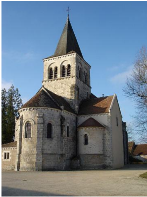
Eglise de La Berthenoux
